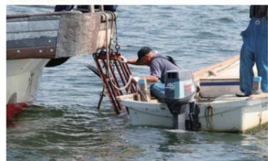
海底にたまったゴミを除去し、硬くなった海底の砂を耕すことで、沈殿した栄養塩を巻上げるとともに、二枚貝等の底生生物が生息しやすい環境を作ります。
